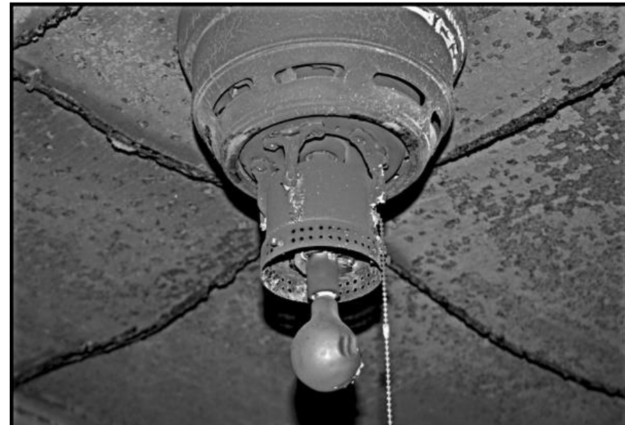
FIGURA 6.3.6.2(b) Bombilla de menos de 25 vatios distorsionada hacia adentro por el calor de la derecha.
